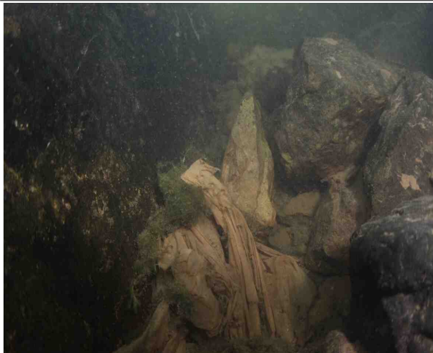
P17하행 교각 기초저면, 상태 양호
