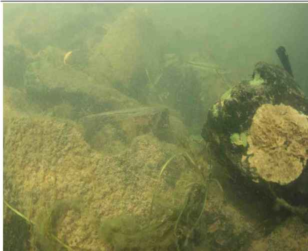
P16하행 교각 기초저면, 상태 양호
