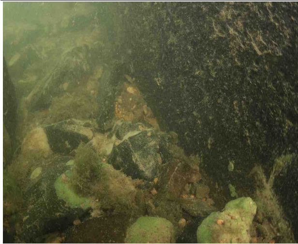
P16하행 교각 기초저면, 상태 양호
