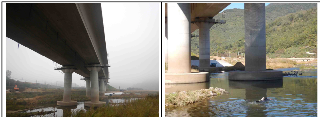
단산대교 전경 및 조사대상 교각
