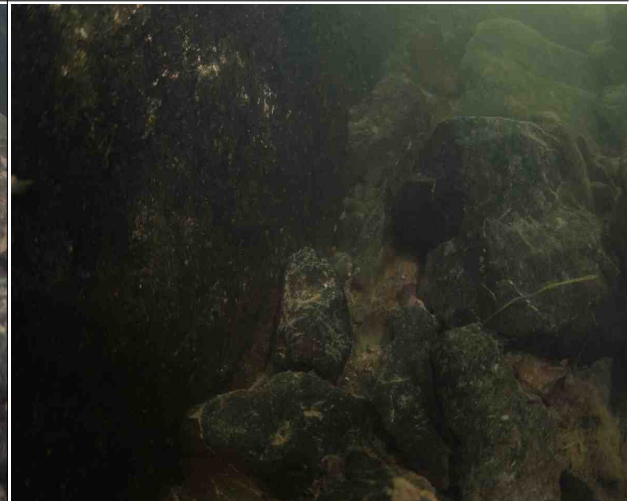
P17하행 교각 기초저면, 상태 양호
