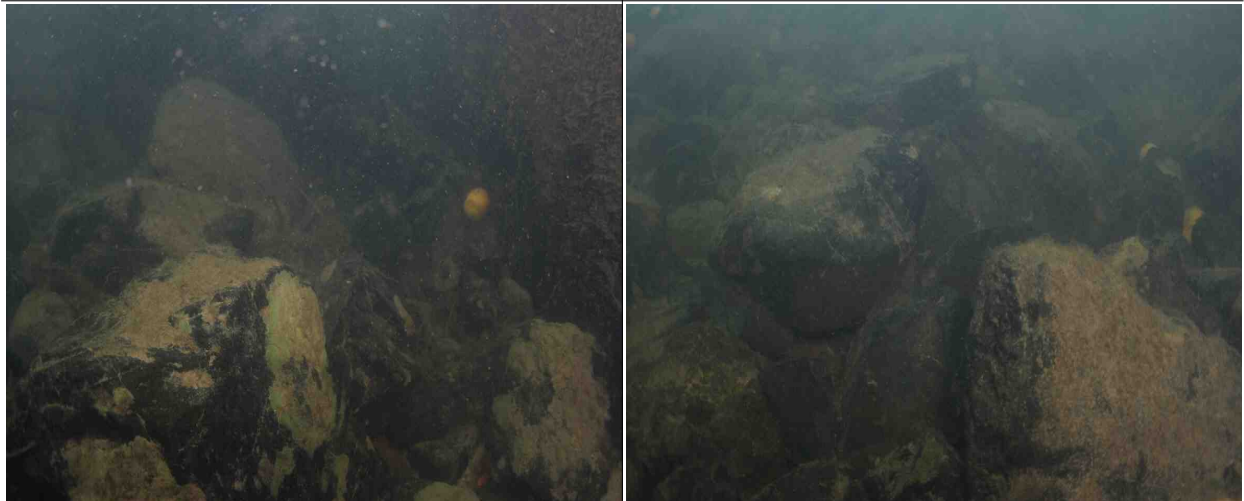
P17상행 교각 보호사석, 상태 양호
