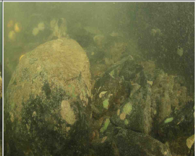
P16하행 교각 기초저면, 상태 양호
