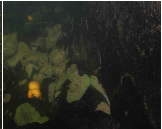
P16하행 교각 기초저면, 상태 양호
