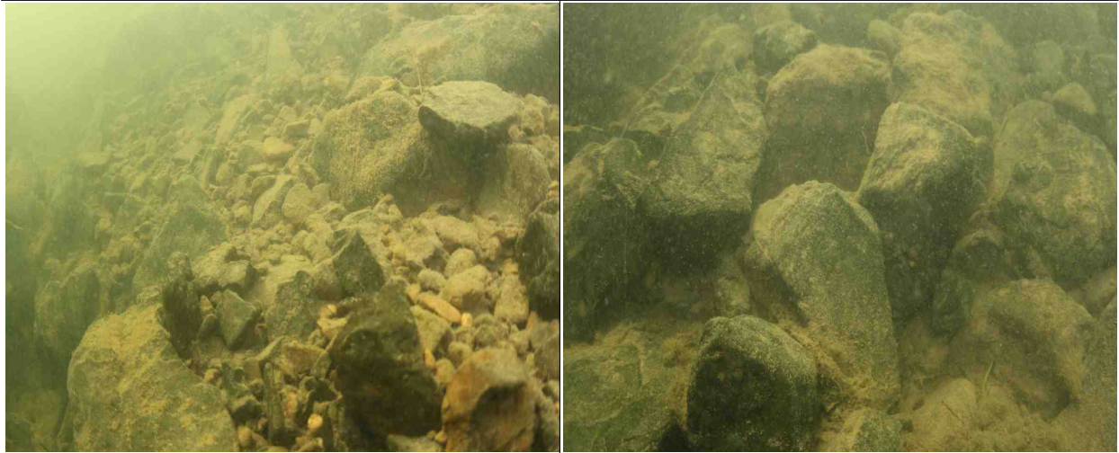
P17하행 교각 보호사석, 상태 양호
