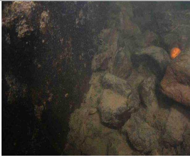
P17하행 교각 기초저면, 상태 양호
