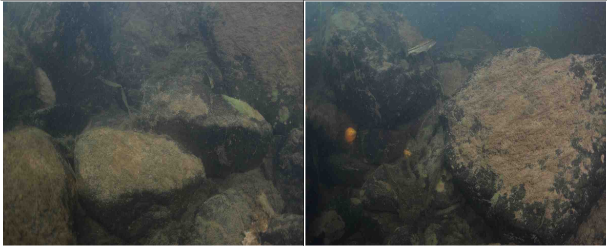
P17상행 교각 보호사석, 상태 양호
