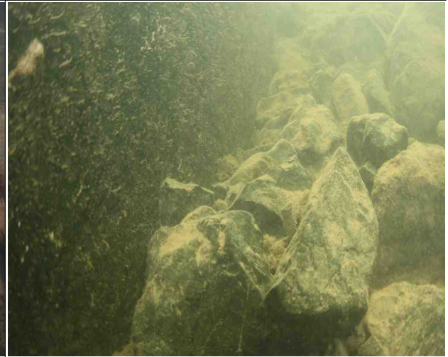
P17하행 교각 기초저면, 상태 양호
